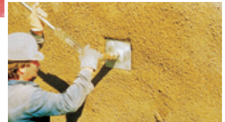
Mise en tension par clé dynamométrique ou par vérin à piston creux
