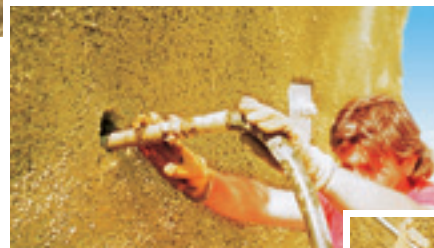
Injection à travers la barre creuse
